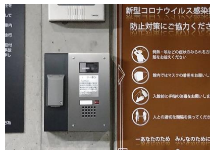
地下駐車場入口
